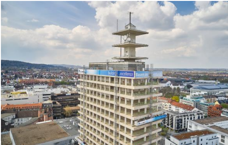
Gesamtansicht.jpg: Die fertig montierten Banner sind weithin sichtbar
